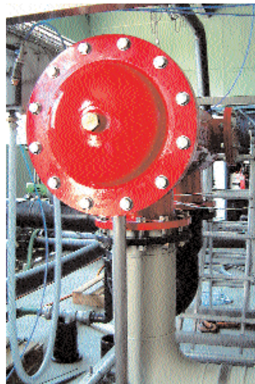
Die Pumpen dienen bei Membrattec SA dem Kult des sauberen Wassers.
