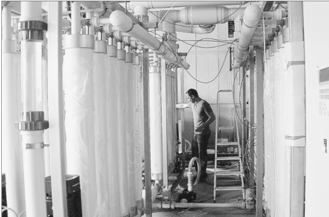
Die Säulenhallen der Membrattec SA machen Begriffe wie Mikrofiltration, Ultrafiltration, Nanofiltration und Umkehrosiose zum Allgemeinut.
