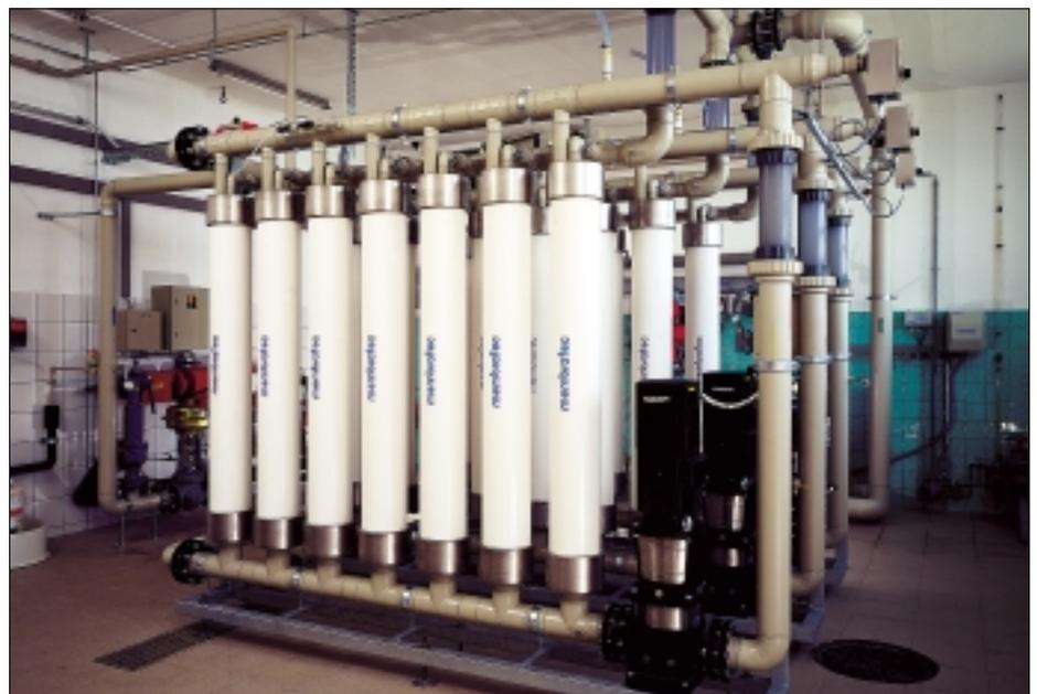
Ultrafiltration: Die Anzahl der Filtermodule richtet sich nach der Qualität des aufzubereitenden Trinkwassers. BILDER: MEMBRATEC
