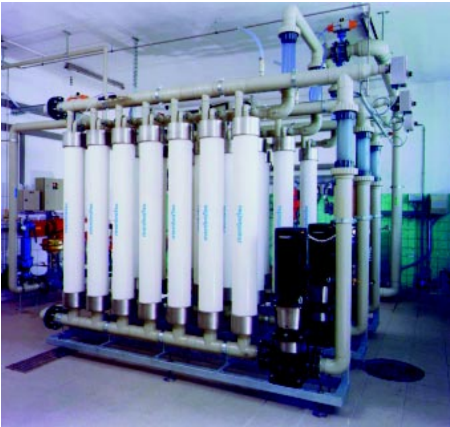
Erste Ultrafiltrations-Anlage der Schweiz für Trinkwasser in Thyon 2000
