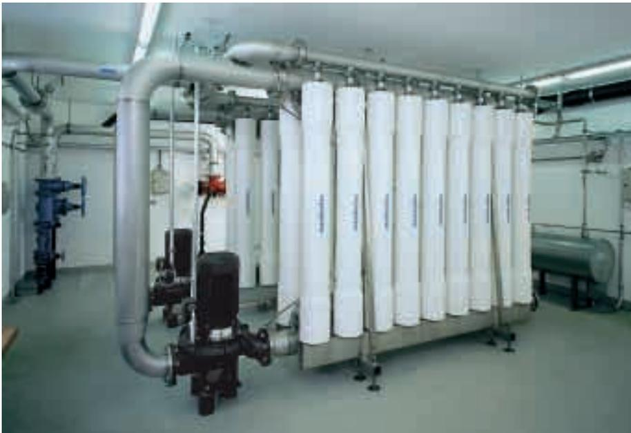
Abb. 5 UF-Anlage Muotathal
