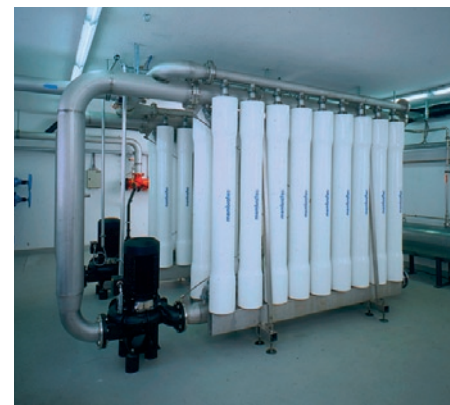
6: UF-Anlage Muotathal (August 2001)
