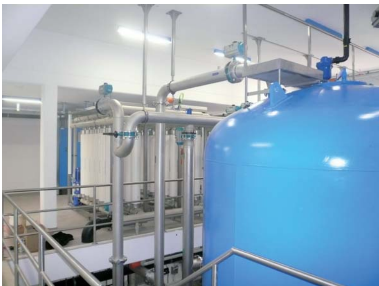
UF-Anlage mit vorge-schalteter GAC-Stufe.
