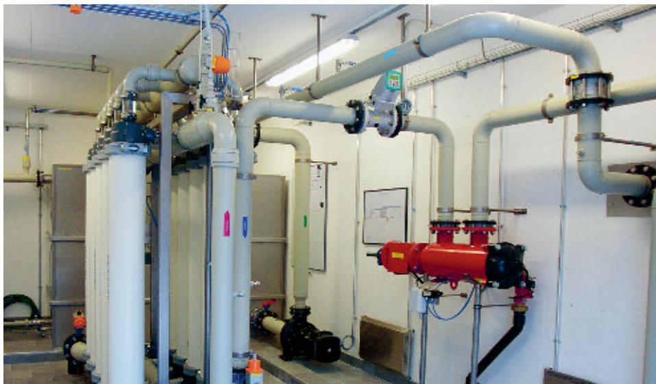
Das Reservoir Gandegg wurde im letzten Jahr ausgebaut und mit einer Ultrafiltrationsanlage ausgestattet.
