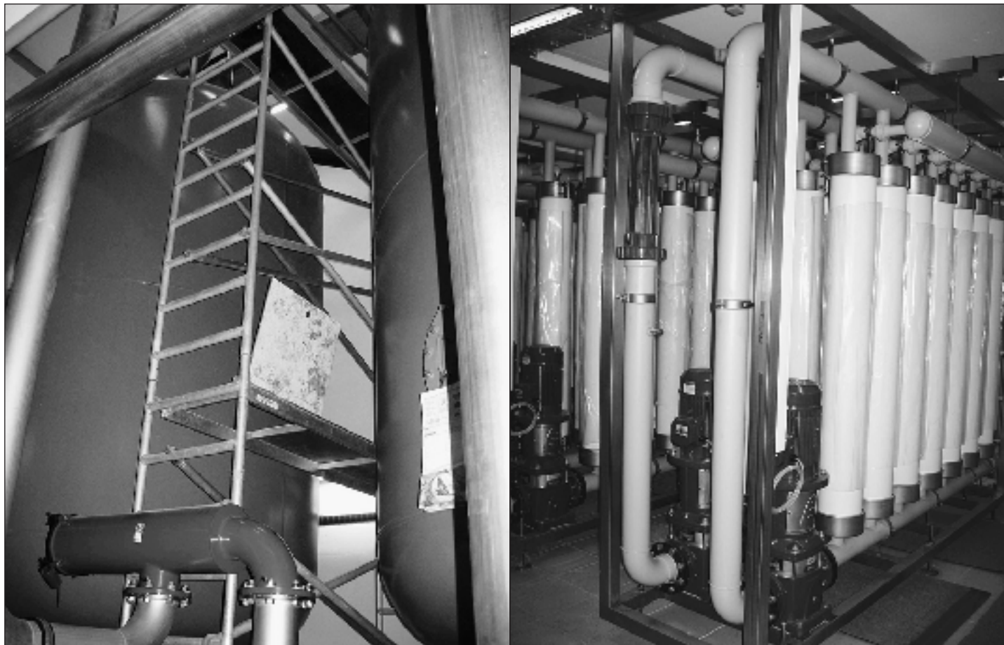
La nouvelle station de traitement de l'eau potable du Syndicat des eaux de Haute-Ajoie est entrée en fonction à Courtemaîche. A droite, les tubes à ultrafiltration, à gauche les cuves pour un traitement au charbon actif.
