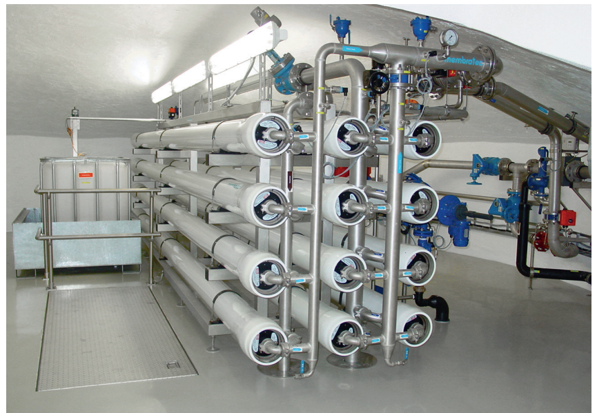
L'installation d'osmose inverse de Zermatt.
