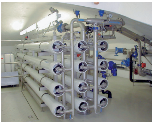
Abb. 2 Umkehrosmose-Anlage im alten Reservoir Wichje.
