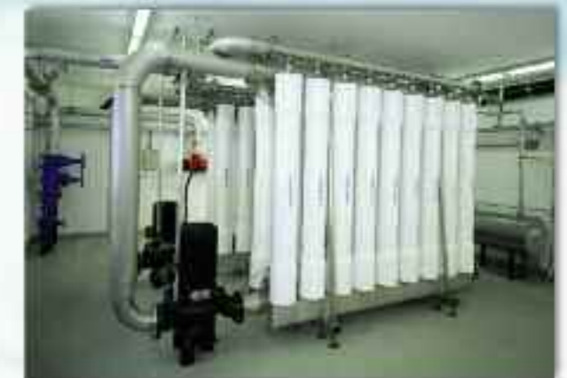
Ultrafiltration-plant 2'200 m³/day
