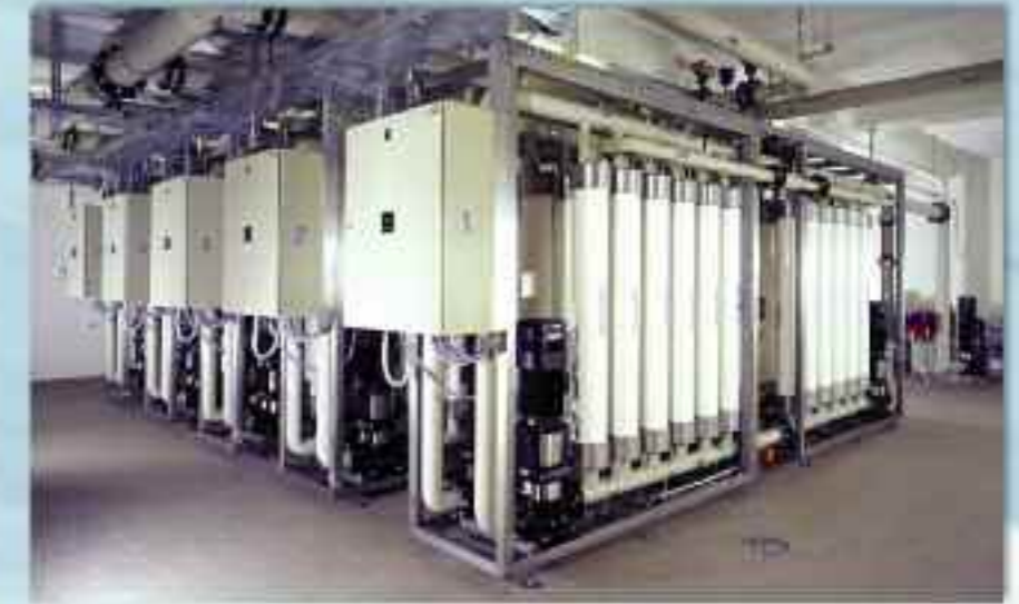
Ultrafiltration-plant 10'000 m³/day
