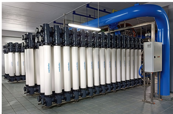
La Jatte (Rouen, FR) - 1300 m 3 /h - SCAP-UF en 2023 Eau de source & de surface | Élimination des résidus de pesticides
